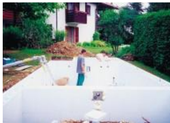
Obr. 2: Konstrukce bazénu z tvarovek ISOSTONE
