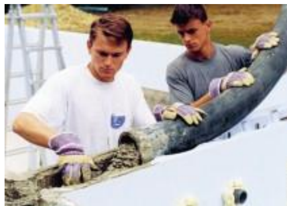
Obr. 3: Vylévání sestavené konstrukce betonem
