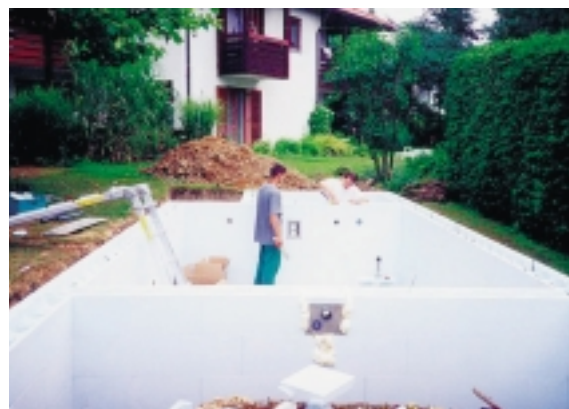
Obr. 2: Konstrukce bazénu z tvarovek ISOSTONE
