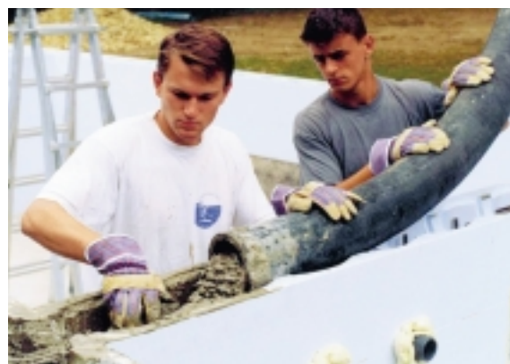
Obr. 3: Vylévání sestavené konstrukce betonem
