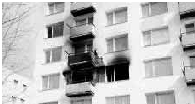
Obr. 9 Při požáru bytové jednotky nedošlo u certifikovaného systému ETICS k rozšíření požáru
